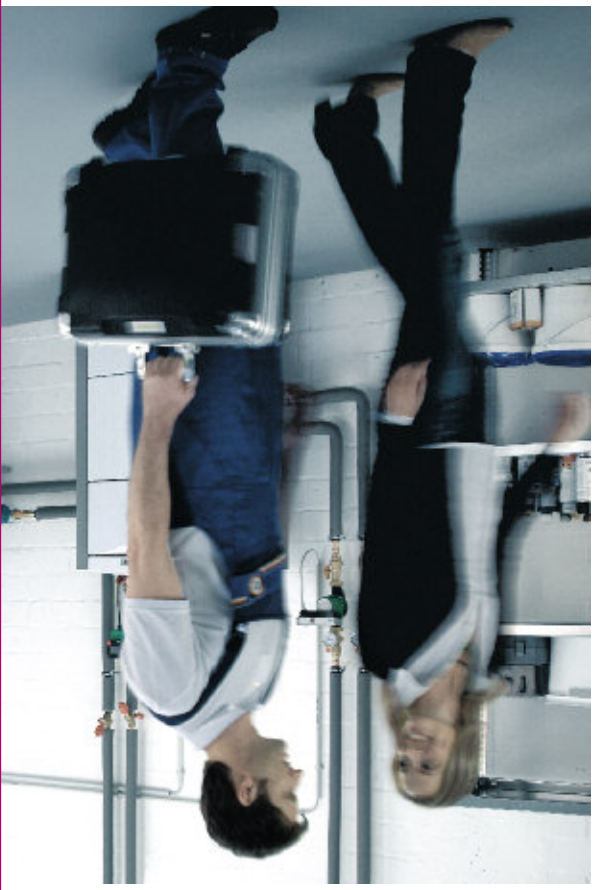
Positionieren des Wilo-DKG-II an einer Trockenläuferpumpe
