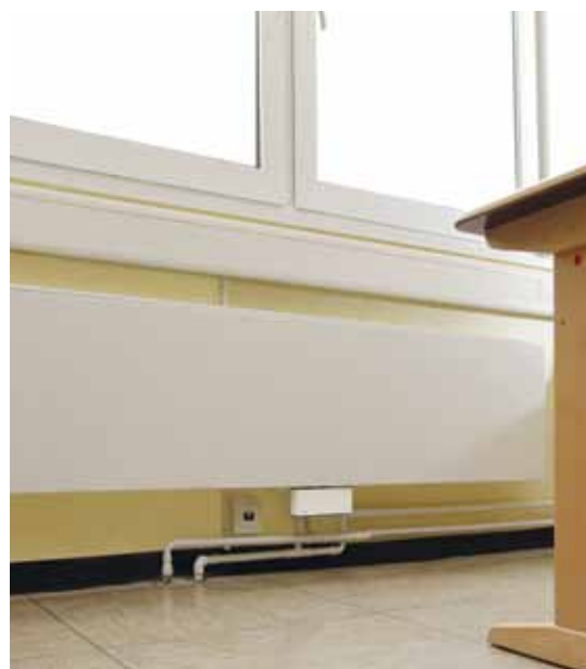
▲ Mit dezentralen Pumpen an den Heizkörpern will die Gemeinde Rommerskirchen langfristig Energiekosten einsparen.
